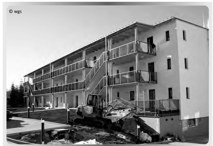
Gestaltung der Außenanlagen ist in vollem Gange
