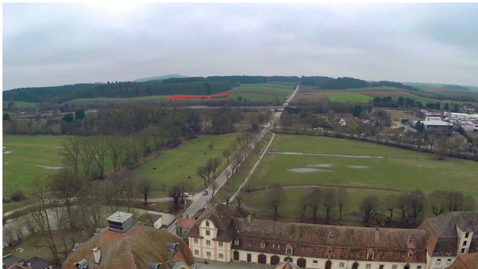
Blick von der Residenz Ellingen nach Westen auf das Planungsgebiet. Die Planbereiche Ellingen VII B und C sind rot markiert.
