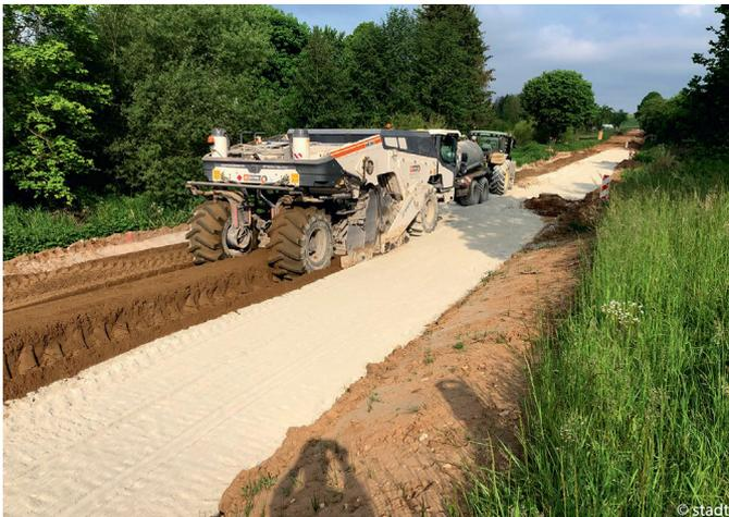
Bodenstabilisierung für bessere Tragfähigkeit
