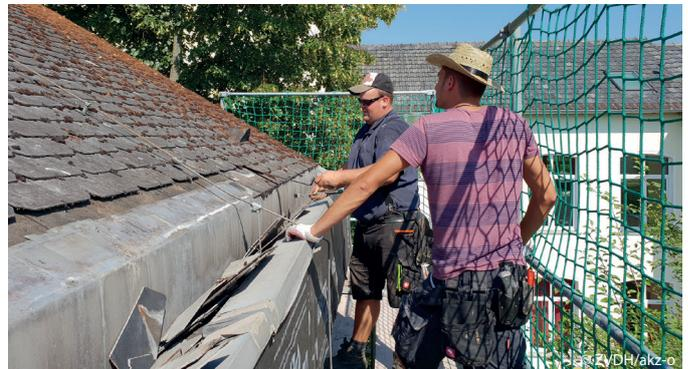
Verklammerung und Befestigung der Dachziegel bzw. -platten werden beim DachCheck geprüft.
