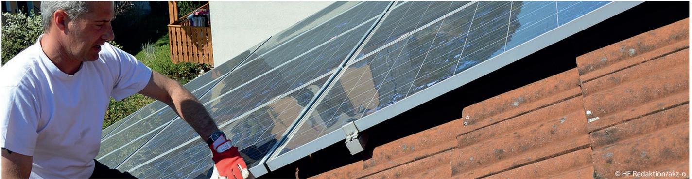
Der qualifizierte Dachdecker prüft die Befestigungen der Solarmodule und begutachtet die Unterkonstruktion im Rahmen des DachChecks.
